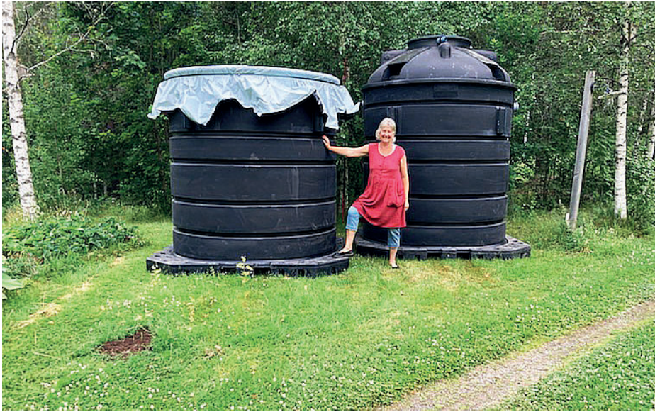
Istället för en trekammarbrunn är det nu två jättestora tunnor, som på ett mycket miljövänligt sätt tar hand om Skogsforsens avlopp.
