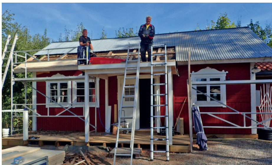
Thomas Sved och medhjälparen Magnus Engman lägger om taket på den gamla ladan, så att det ska hålla för moderna solceller.
