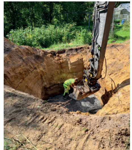
Tunnorna grävdes förstås inte ner med en liten spade. Men med hjälp av Bäcktorparn's gräv och entreprenad gick det bra.
