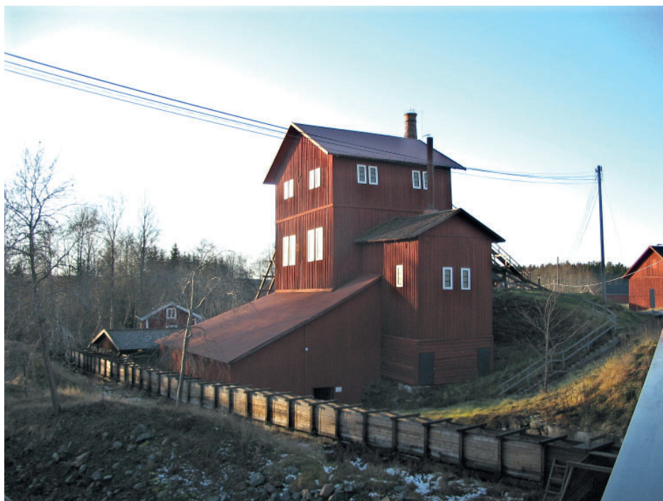
Vattenrännan som går till vattenhjulet vid hyttan läcker lite för mycket och behöver restaureras. Och hyttan behöver rödmålas. Det är ett par av de saker som noterades vid årets hyttstämma. Förhoppningsvis kan något bidrag från Riksantikvarieämbetet fås för sådant underhåll.
