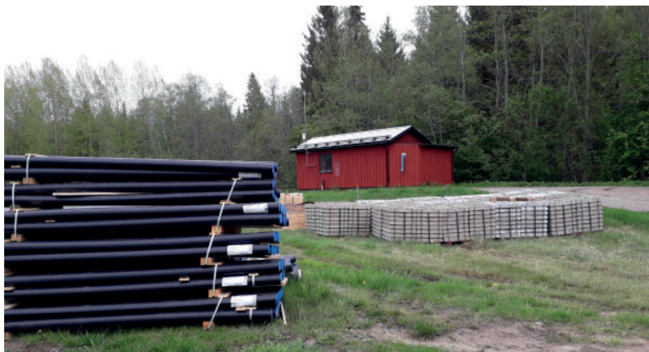
Ett upplag av vattenledningar och betongfundament vid reningsverket i Löa betyder att ett nytt projekt för det kommunala dricksvattnet i Löa är på gång.
