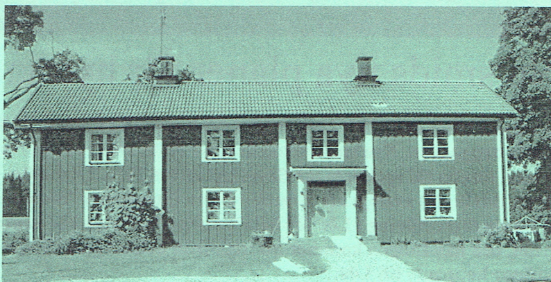
Verandan togs bort och den fjärde sektionen byggdes med källare under 1975.
