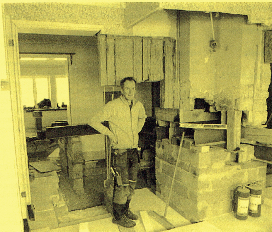
Hussvamp i Missionshuset har givit Torbjörn Lie ett stort men lärorikt extrajobb. Numera vet han hur man kapar en 20 ton tung skorsten underifrån.
